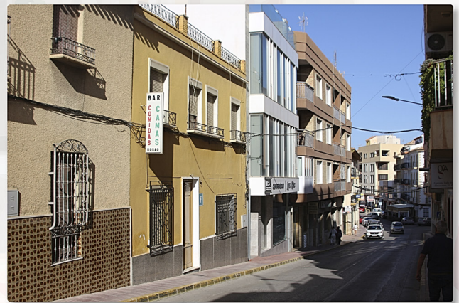
Fachada de la Fonda del Rosao
